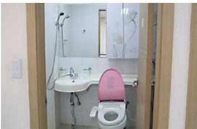
숙소내 욕실 (비데 설치)
